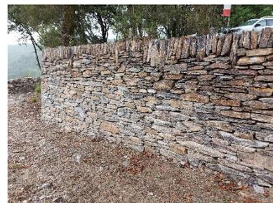
Mur de soutènement sous le parking du Skyte construit dans le respect des traditions locales
