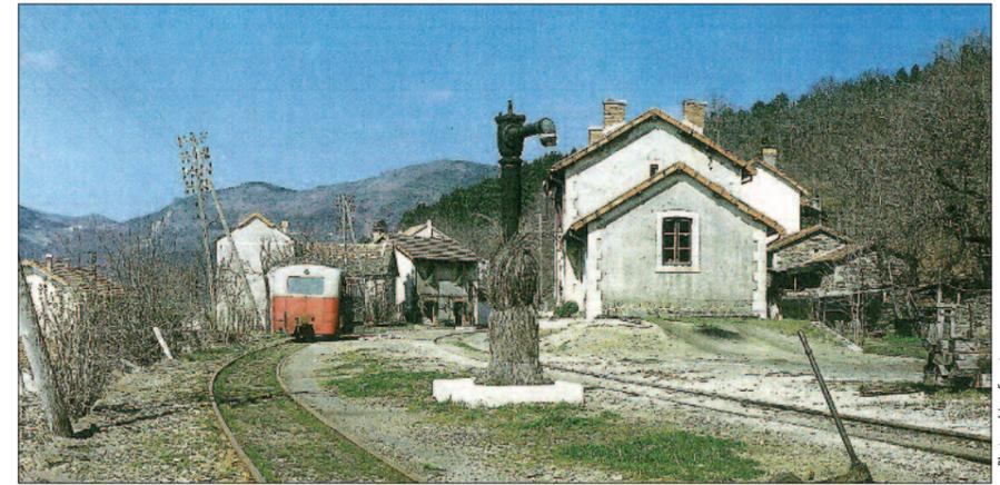
La gare de St-Privat disposait de deux grues hydrauliques en charge depuis un réservoir en maçonnerie de 240 m3. Sur cette photo de mars 1964 on voit la grue (côté Ste-Cécile), emmaillottée dans des fagots de genêts par mesure antigel. A gauche, stationnant en gare, l'autorail De Dion Bouton n°202. De nos jours, les pierres de l'embase en maçonnerie d'une des deux grues sont toujours présentes à côté de la mairie.
